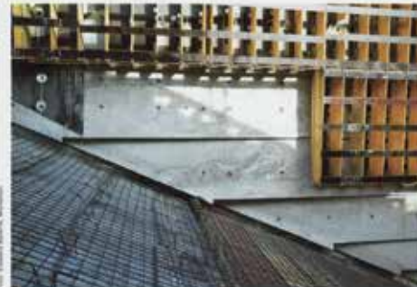
Dieselbe Längswand, hier noch teilweise in der Schalung
