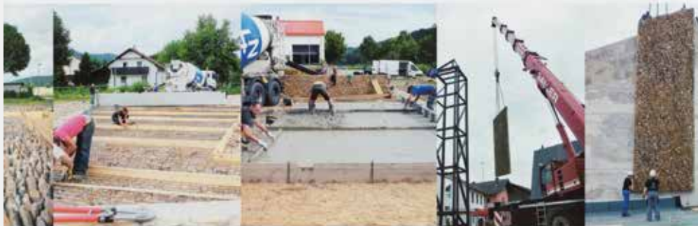
Fertigung und Aufhängung der Fassadenelemente
