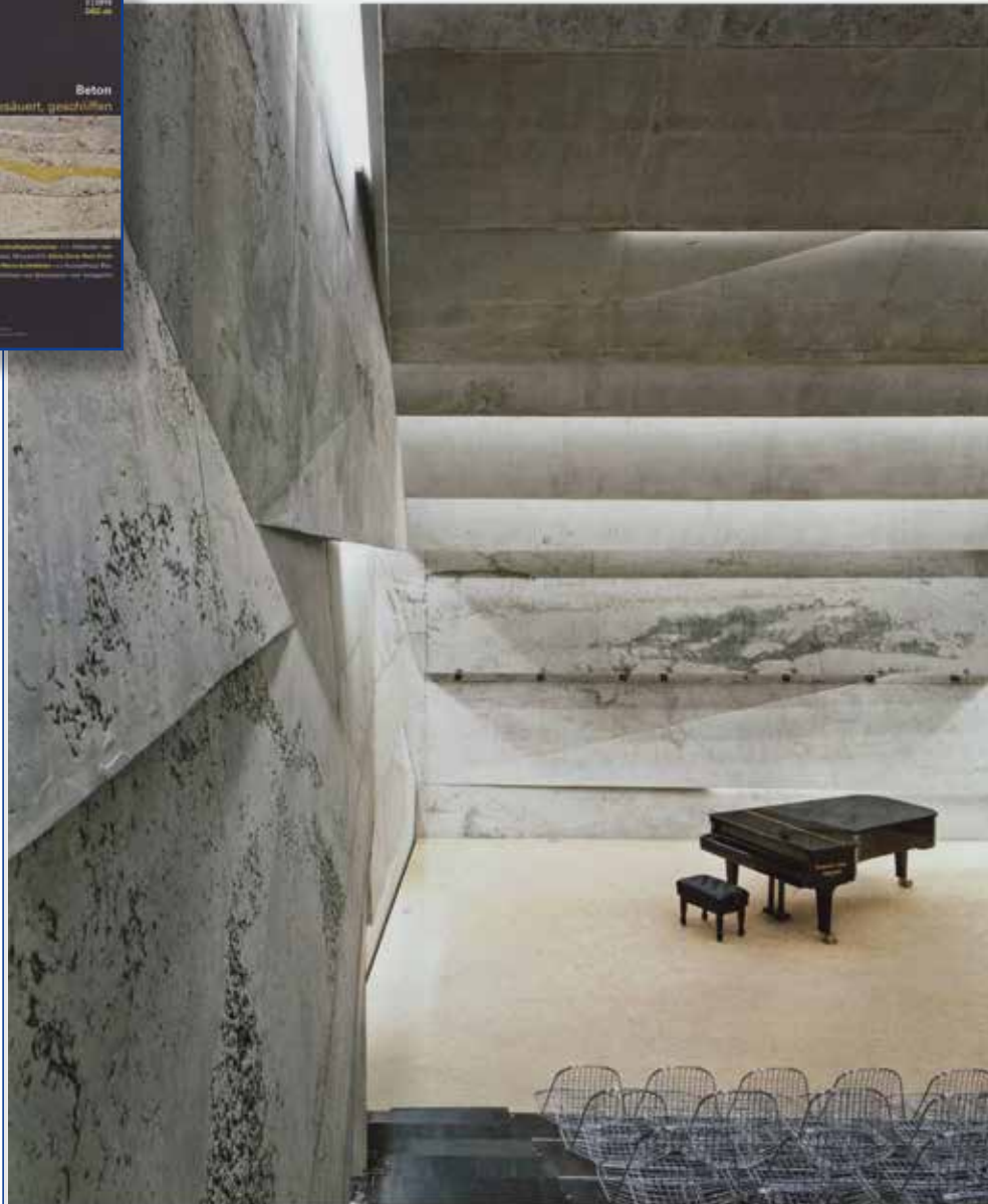
Betonschäden (Nester) als in den Moonolithen integrierte Mittenabsorber, die günstiger (und schöner) wohl nicht zu realisieren sind
