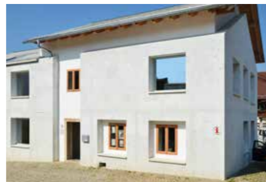
Abb. oben und links Penzkoferhaus in Viechtach Die Grundrisse des abgerissenen Vorgängerhauses wurden in Kuben, Streifen und Fragmente zerlegt und aus Fertigteilen in Leichtbeton LC8/9 zu neuen Formen geschichtet. Ebenso bestehen die Dachelemente aus Leichtbetonfertigteilen, die dem Wohnraum einen beeindruckenden Struktur geben.
