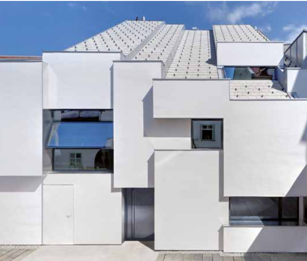
Abb. oben und links Penzkoferhaus in Viechtach Die Grundrisse des abgerissenen Vorgängerhauses wurden in Kuben, Streifen und Fragmente zerlegt und aus Fertigteilen in Leichtbeton LC8/9 zu neuen Formen geschichtet. Ebenso bestehen die Dachelemente aus Leichtbetonfertigteilen, die dem Wohnraum einen beeindruckenden Struktur geben.
