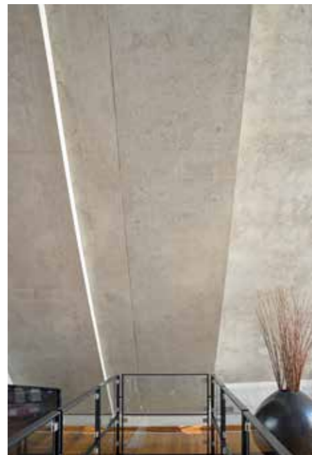
Abb. oben und links Penzkoferhaus in Viechtach Die Grundrisse des abgerissenen Vorgängerhauses wurden in Kuben, Streifen und Fragmente zerlegt und aus Fertigteilen in Leichtbeton LC8/9 zu neuen Formen geschichtet. Ebenso bestehen die Dachelemente aus Leichtbetonfertigteilen, die dem Wohnraum einen beeindruckenden Struktur geben.
