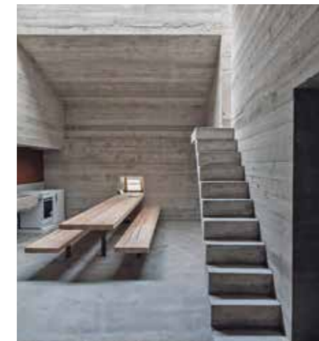
Verschiedene Oberflächenstrukturen je nach Schalungstechnik
